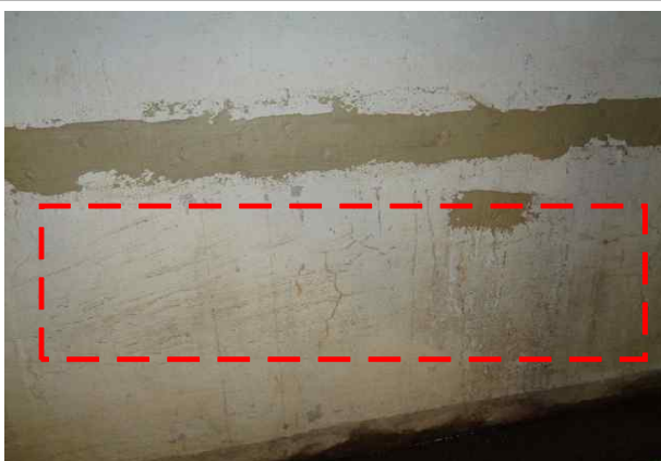
내부 지하층 벽체 망상균열 (A=0.3m×11.0m)
