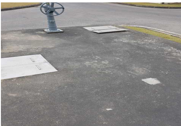
최종침전지(2계열) 분배조 바닥 양호
