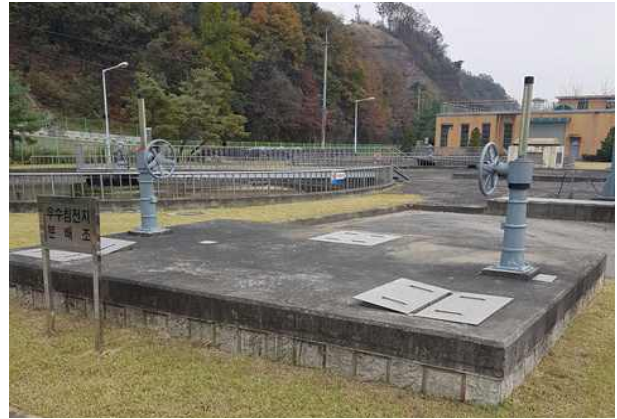
최종침전지(2계열) 분배조 외부 전경
