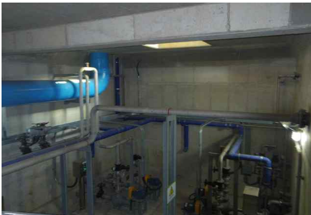
지하층 내부 전경
