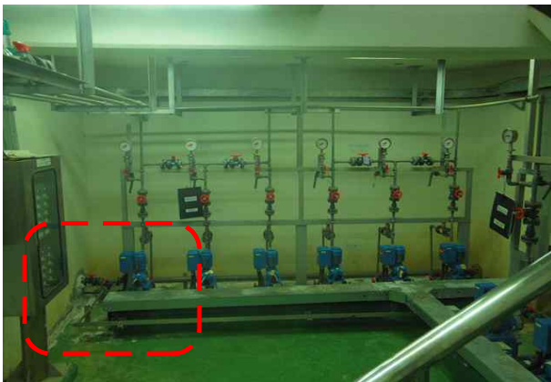
내부 지하층 바닥, 박리 및 오염 (A=5.0m×5.0m)
