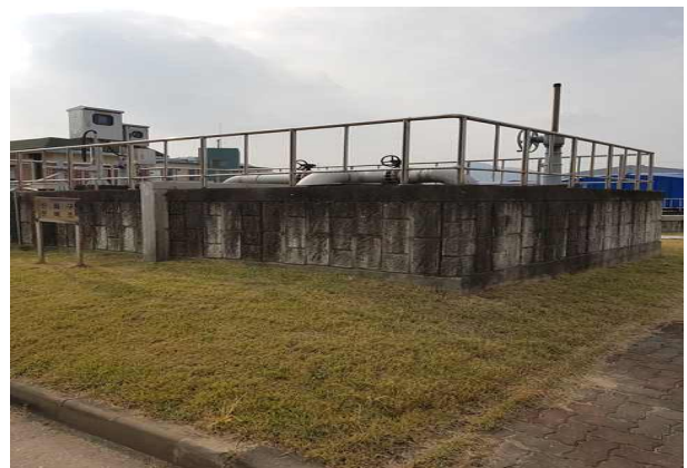
외부 벽체 콘크리트 표면상태 양호
