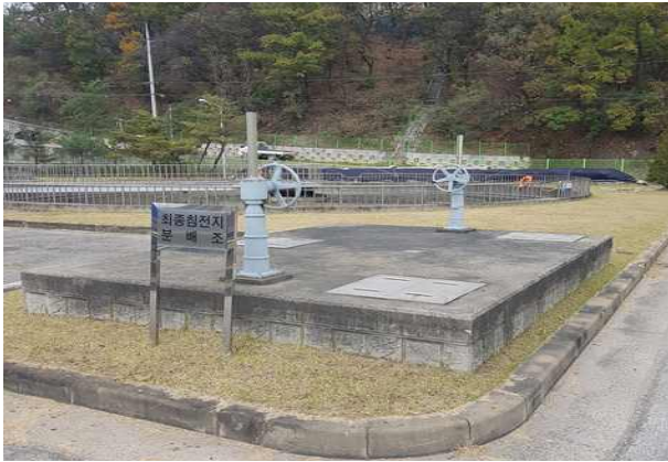
최종침전지 분배조(1계열) 외부 전경
