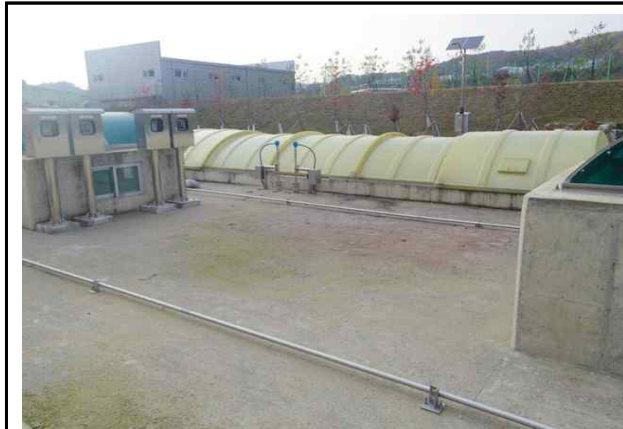
외부 바닥, 콘크리트 박리 (A=10.0m×10.0m)
