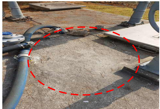
유입맨홀 외부 바닥, 표면열화 (A=3.0m×3.0m)
