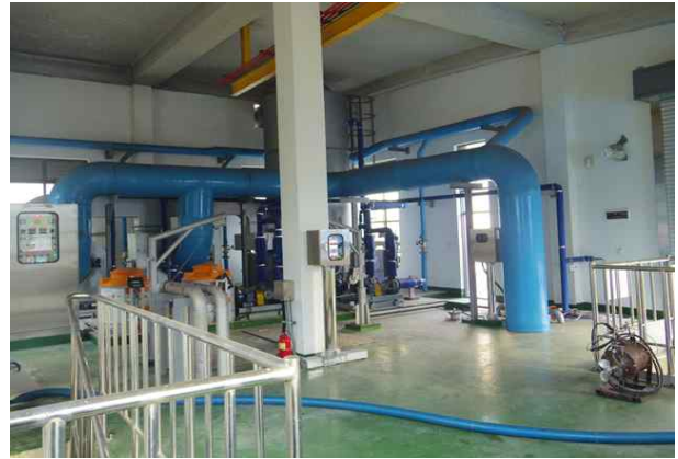
1층 내부 전경
