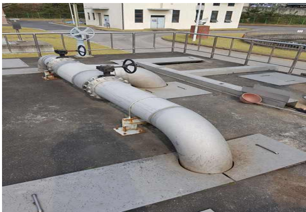
외부 바닥 콘크리트 표면상태 양호
