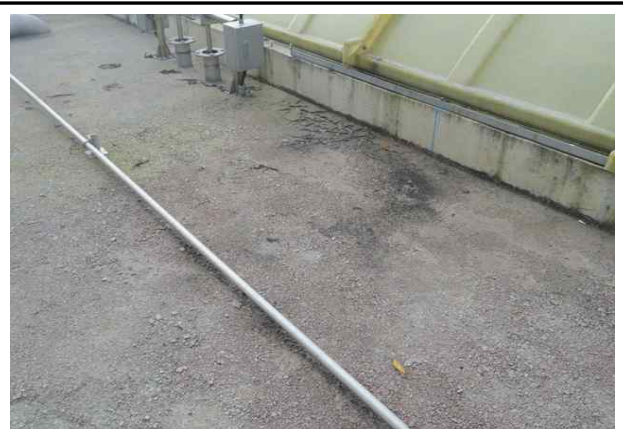
외부 바닥, 콘크리트 박리 (A=10.0m×10.0m)
