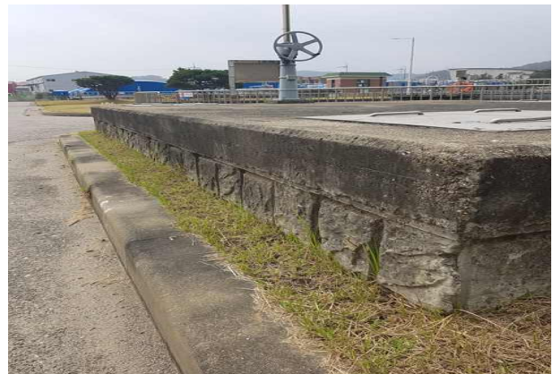
최종침전지 분배조(1계열) 벽체 양호
