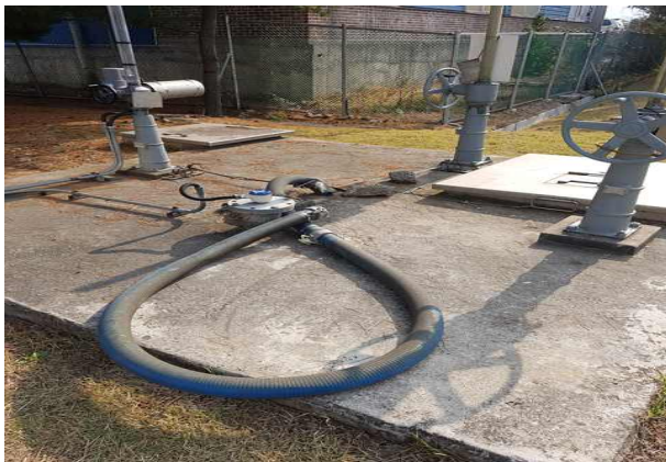
유입맨홀 외부 바닥, 표면열화 (A=3.0m×3.0m)
