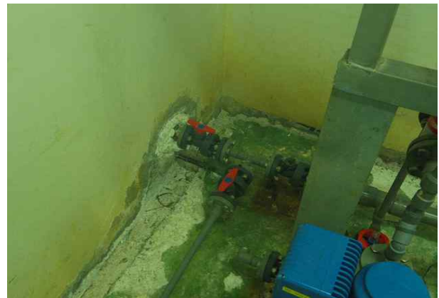
내부 지하층 바닥, 박리 및 오염 (A=5.0m×5.0m)
